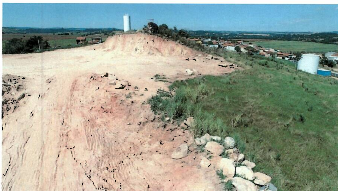
Foto 07 – Área do reservatório com o talude praticamente “em pé”.
